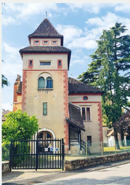
~ Ein Adelsansitz? Hinter dem schlosschenartigen Gebäude verbirgt sich die erste, 1903 errichtete Umspannstation des Eppaner Gemeindegebiets.
