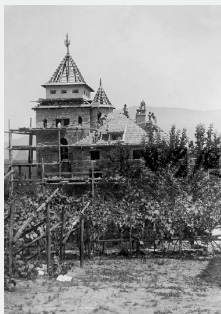
~ Das Stromschlössl in St. Michael Eppan in der Bauendphase im Jahr 1903.
