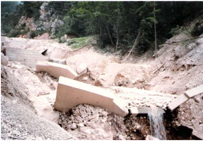
~ Die enorme Gewalt der Mure: Herausgerissene und zerstörte Staustufen im Bachlauf
