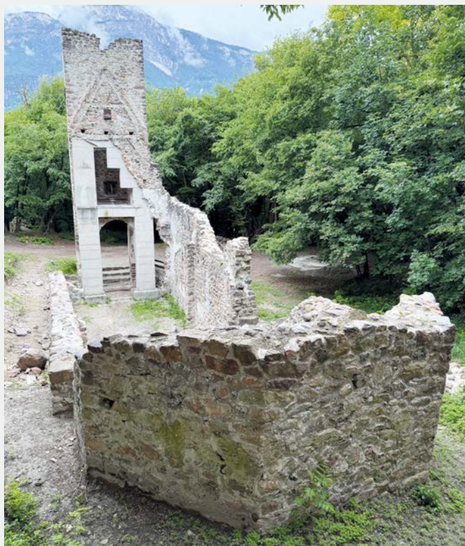
~ Die Ruine der St.-Margarethen-Kirche in der Klaus bei Terlan wurde vergangenes Jahr saniert
