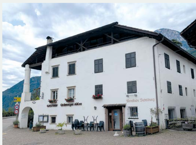
^ Der „Schwarze Adler“ heute – vorbildlich saniert, aber in seiner baulichen Substanz nicht verändert
